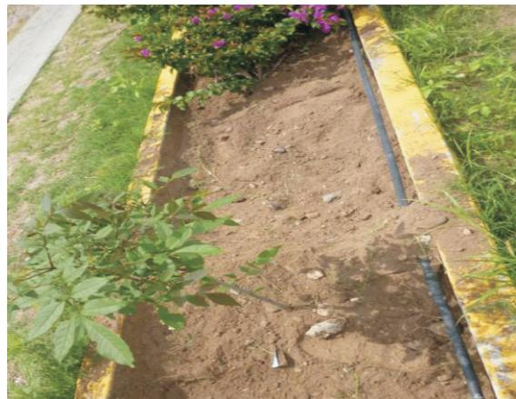
Sustitución de Sistema de Riego en camellón las Buganvillas y Avenida de acceso principal. Se implementa 400 metros de manguera Stru-Pack ½ pulgada y 500 goteros reguladores, con una inversión aproximada a los \$7,203.00.
